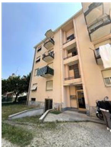
Vista edificio da cortile interno
