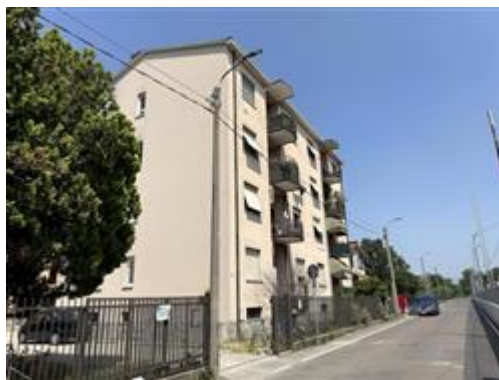
Vista edificio da Via Brennero fronte sud est
